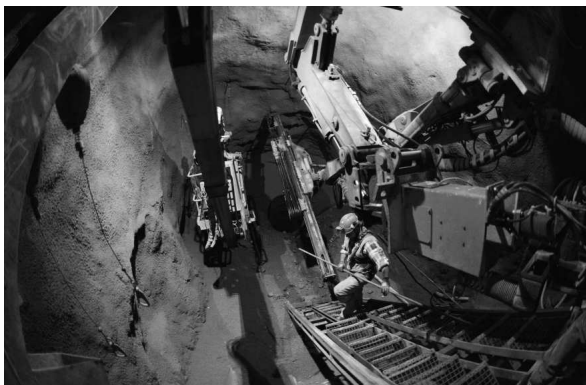
DER VORTRIEB IM UNTERSTEN TUNNEL GEHT KONTINUIERLICH VORAN.
