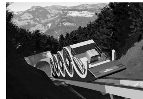
Neue Standseilbahn auf den Stoos.
