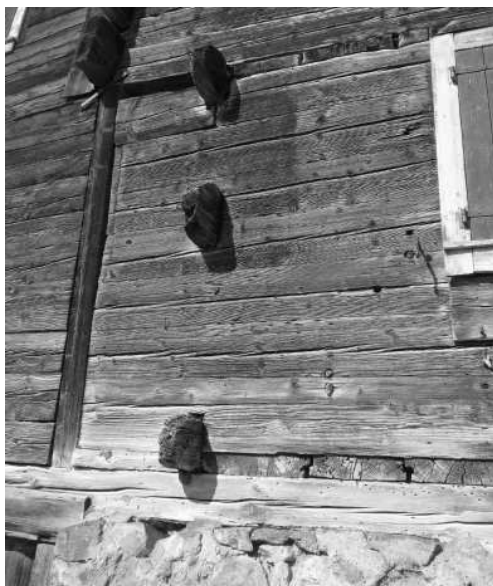
AN DER HAUPTFASSEDE DES HAUSES TANNEN 3 SIND DIE ABGERUNDETEN EINZELVORSTÖSSE UND DIE FASSADENBÜNDIGEN BODEN- BZW. DECKENBOHLEN GUT ZU ERKENNEN. FOTO: MICHAEL TOMASCHETT, SCHWYZ.
