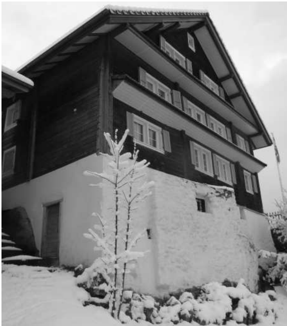
DAS HAUS SCHLÖSSLI AN DER OBERGASSE BESITZT EINEN SEHR HOHEN MAUERSOCKEL MIT UNREGELMÄSSIGEN STRUKTUREN. FOTO: MICHAEL TOMASCHETT, SCHWYZ.
