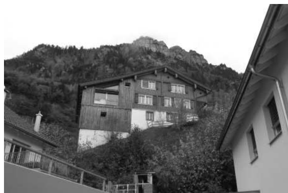
DAS VERMUTLICH KURZ NACH 1558 ERRICHTETE HAUS GUBEL 2 WURDE MEHRMALS UM- UND ANGEBAUT. FOTO: MICHAEL TOMASCHETT, SCHWYZ.
